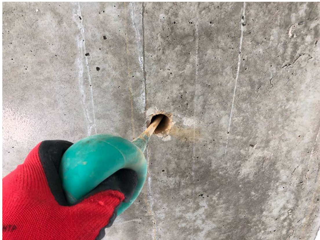
Рис. 4.2.2. Продувка отверстия от пыли в монолитном железобетонном пилоне 1-го этажа в осях 13/Ф/2
