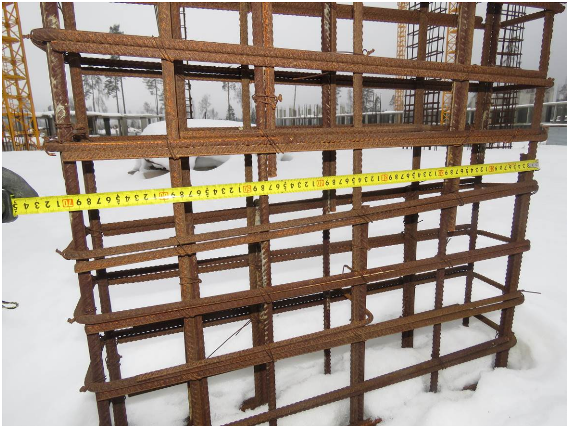
Рис. 3.2.7. Замер шага вертикальных стержней арматуры в выпусках монолитного пилона 1-го этажа секции 2
