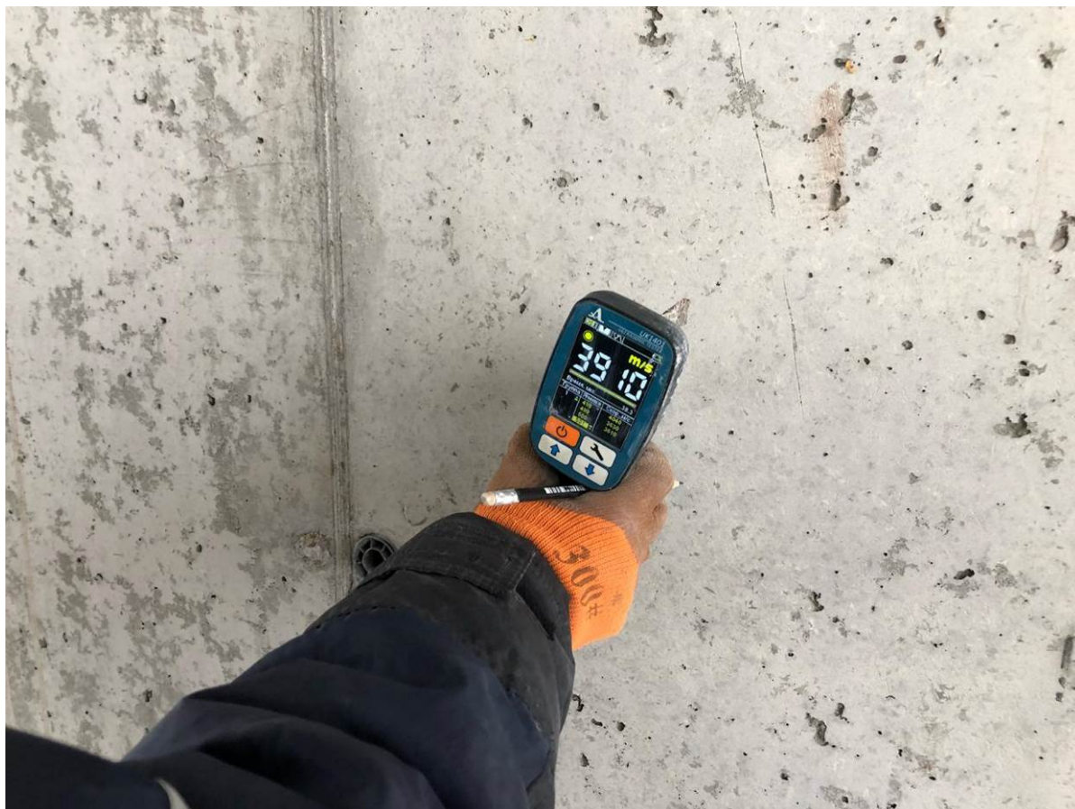
Рис. 4.3.1. Определение прочности бетона в монолитном железобетонном пилоне 1-го этажа ультразвуковым методом прибором УК 1401
