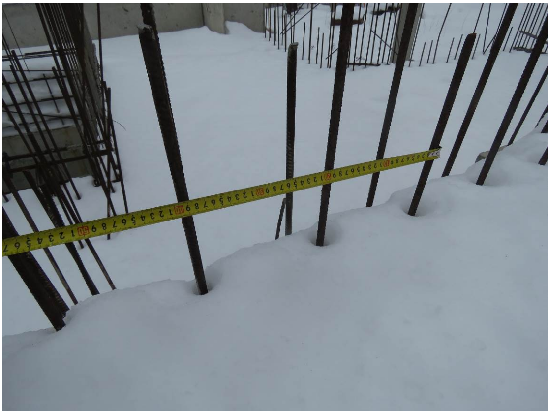
Рис. 3.2.8. Замер диаметра вертикального армирования в монолитной стене в уровне 2-го этажа
