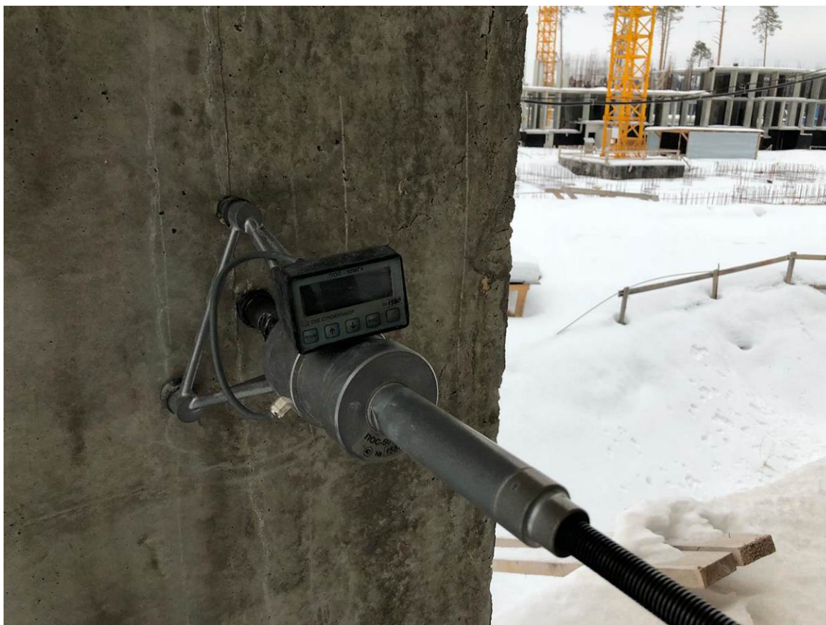
Рис. 4.2.4. Испытание бетона монолитного железобетонного пилона в осях 13/Ф/2 методом отрыва со скалыванием прибором ПОС 50МГ-4
