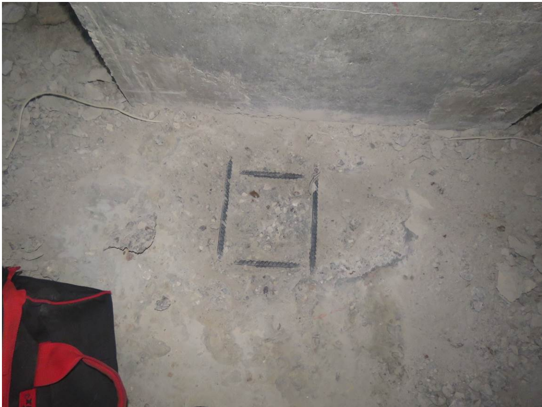
Рис. 3.1.7. Общий вид вскрытия фундаментной плиты в верхней зоне на пересечении осей РР-ТТ и 11-14
