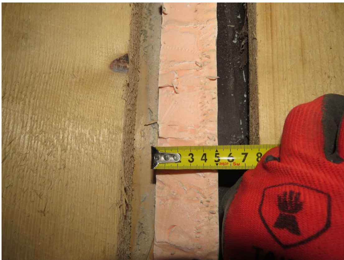
Рис. 3.1.6. Деформационно усадочный шов заполнен пенополистиролом толщиной 50 мм
