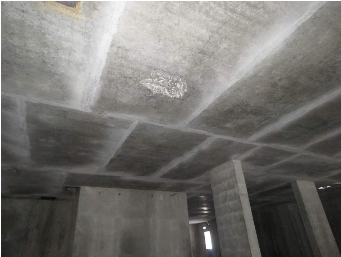
Рис. 3.3.1. Общий вид монолитной ж.б. плиты перекрытия подвального этажа, секция 2
