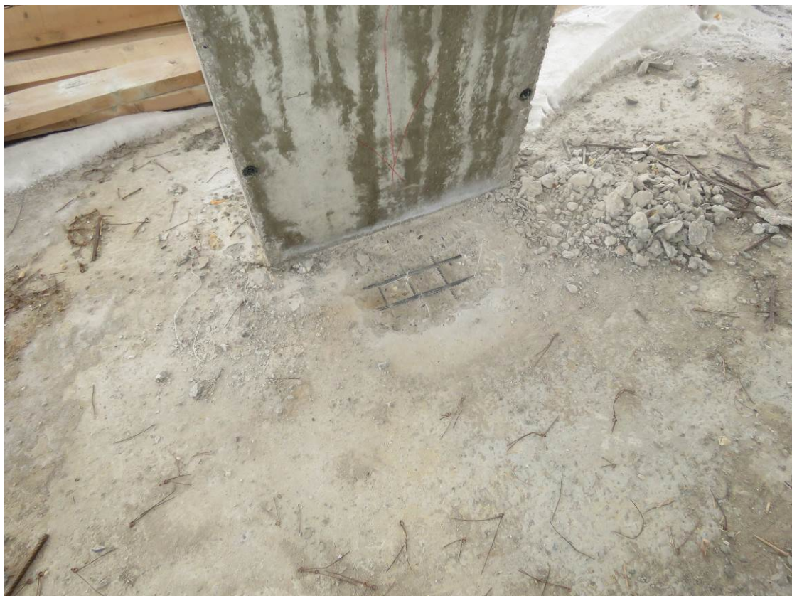
Рис. 3.3.4. Общий вид участка вскрытия плиты перекрытия подвала (зона верхнего армирования)
