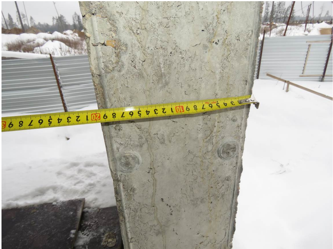
Рис. 3.2.3. Замер сечения монолитного ж.б пилона 1-го этажа (200 мм)
