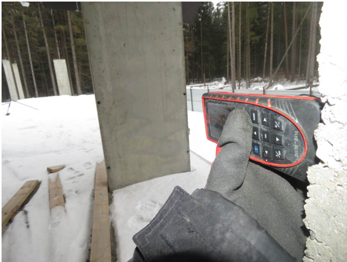
Рис. 3.2.5. Замер шага монолитных пилонов 1-го этажа
