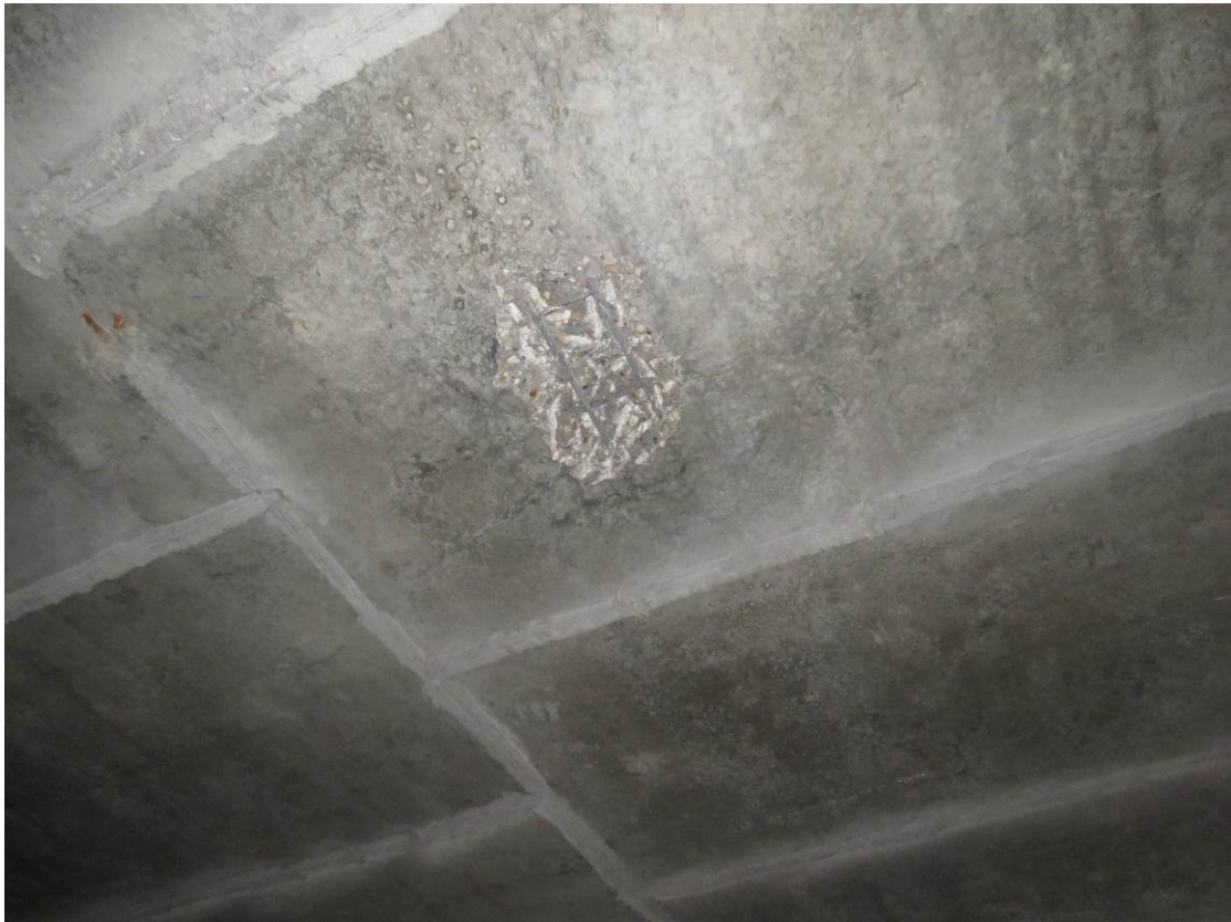
Рис. 3.3.3. Общий вид участка вскрытия плиты перекрытия подвала (зона нижнего армирования)
