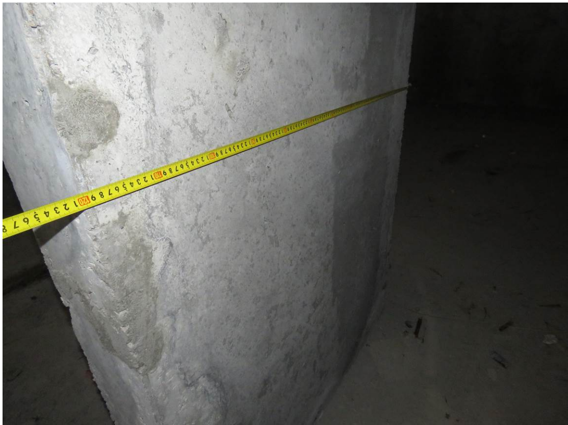
Рис. 3.2.4. Замер ширины монолитного ж.б пилона подвального этажа (1200 мм)
