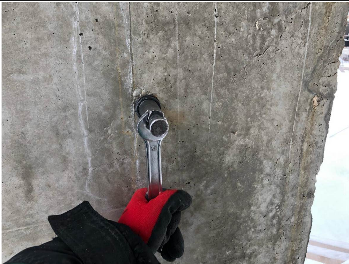
Рис. 4.2.3. Установка анкерного устройства и тяги в отверстии монолитного железобетонного пилона в осях 13/Ф/2
