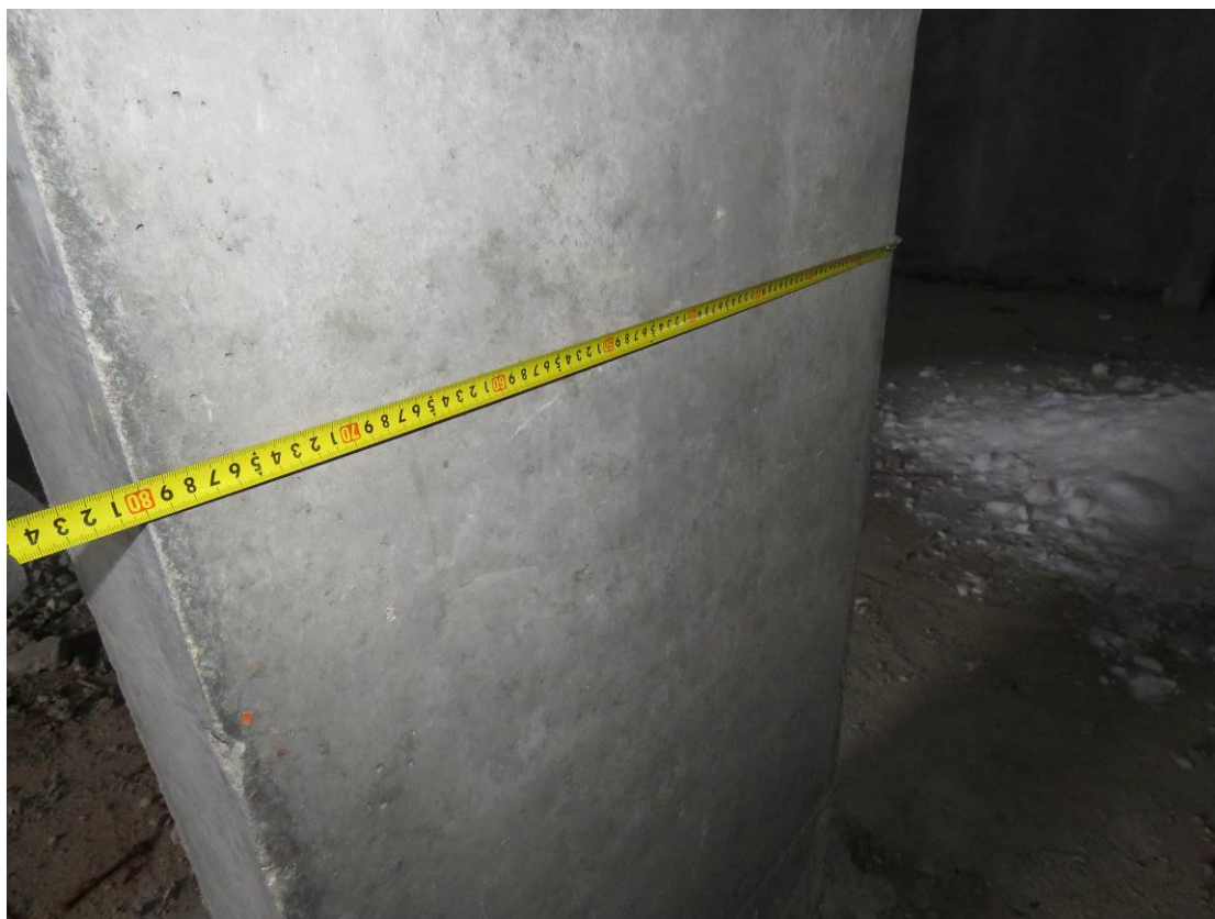
Рис. 2.2. Уточнение ширины пилона подвального этажа секции 2
