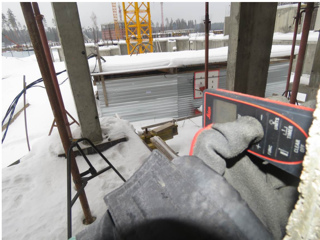
Рис2.3. Замер шага монолитных пилонов 1-го этажа секции 5 при помощи лазерного дальномера
