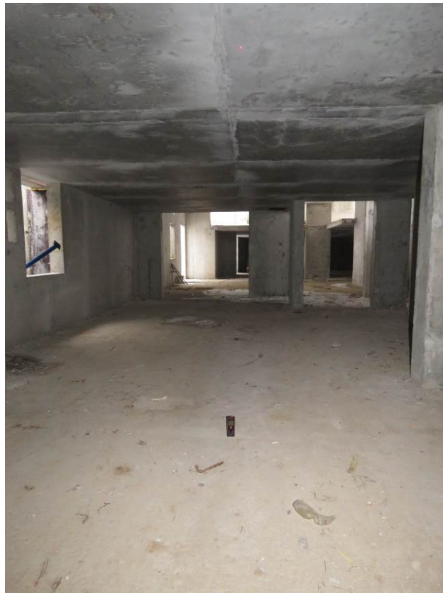
Рис. 2.2. Замер высоты помещений подвального этажа при помощи лазерного дальномера
