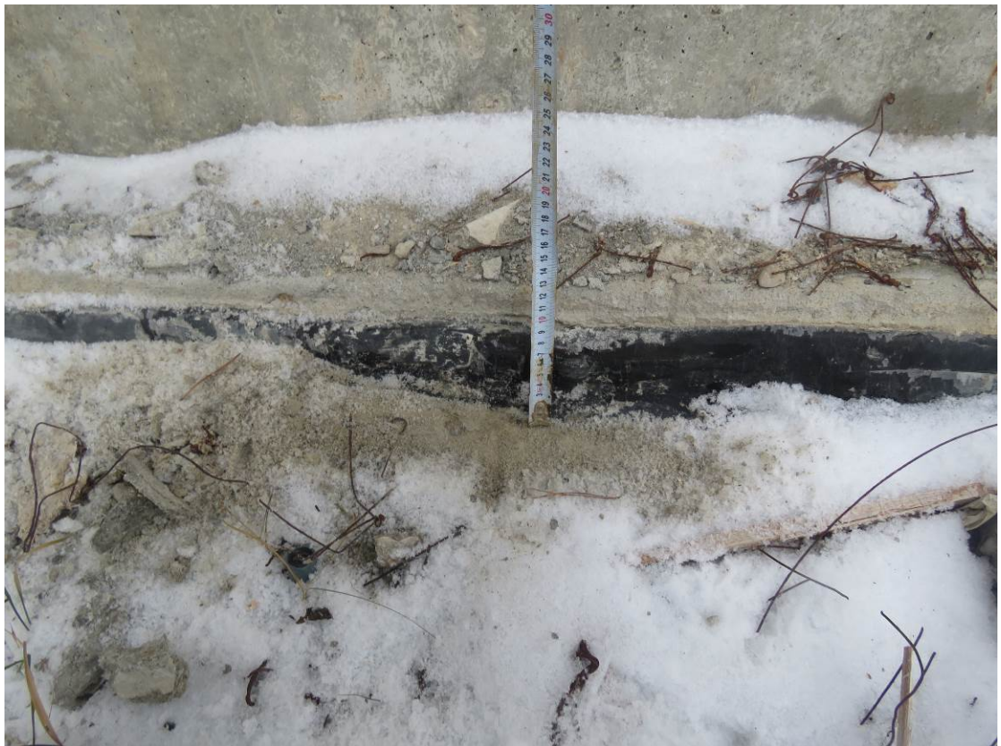
Рис. 3.1.4. Уточнение толщины бетонной подготовки ( 100 мм)
