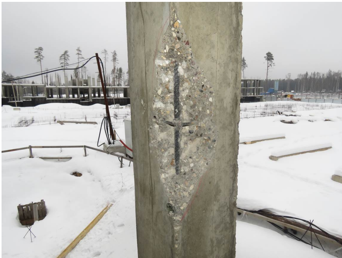
Рис. 3.2.6. Общий вид вскрытия монолитного пилонa 1-го этажа секции 5
