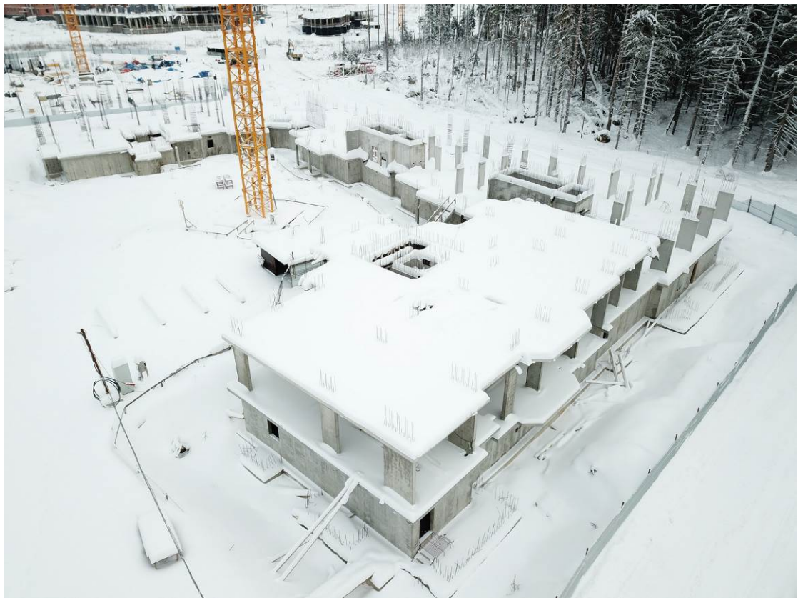
Рис. 1.1. Вид возведенных конструкций в осях Ф/2 / 12-19
