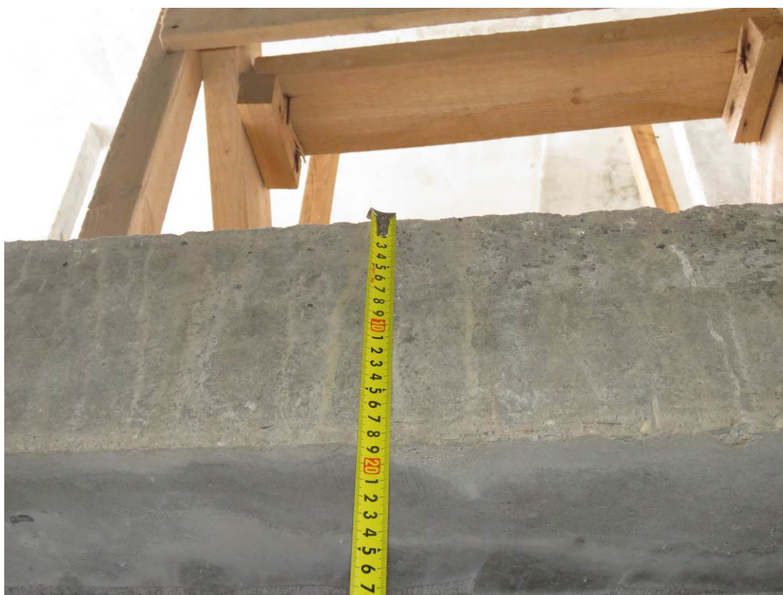
Рис. 2.4. Уточнение толщины монолитного ж/б перекрытия 1-го этажа
