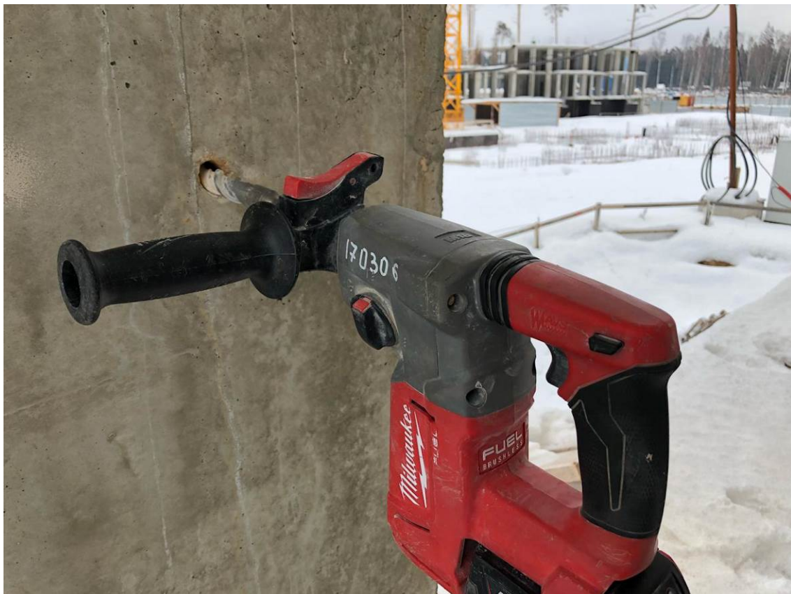
Рис. 4.2.1. Сверление отверстия в монолитном железобетонном пилоне 1-го этажа в осях 13/Ф/2
