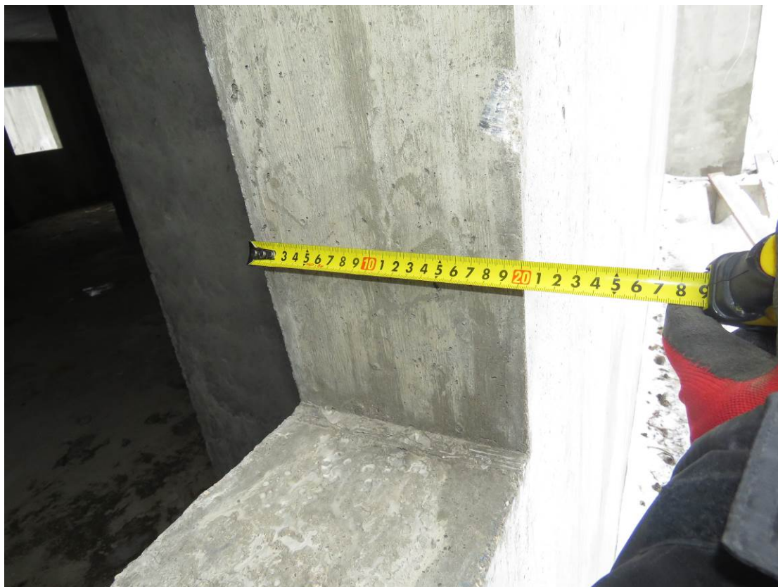
Рис. 2.3. Уточнение толщины наружной монолитной стены подвала
