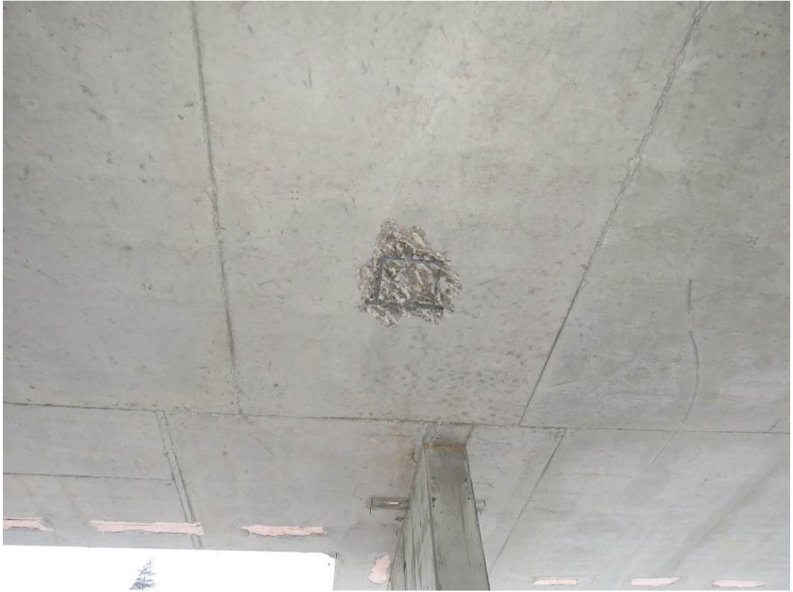
Рис. 3.3.6. Замер шага рабочей арматуры плиты перекрытия 1-го этажа ниже армирование
