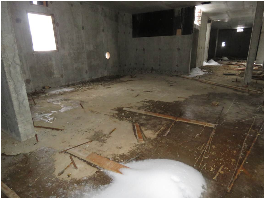
Рис. 3.1.2. Общий фундаментной плиты в осях Г/1-М/1 22-27
