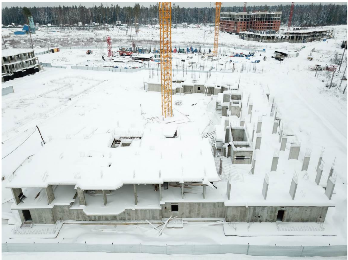
Рис. 1.2. Вид возведенных конструкций вдоль оси 12
