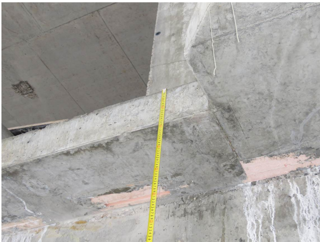
Рис. 3.3.2. Замер толщины монолитной ж.б. плиты перекрытия ( 180 мм) в осях Ф/2-У/2 / 18
