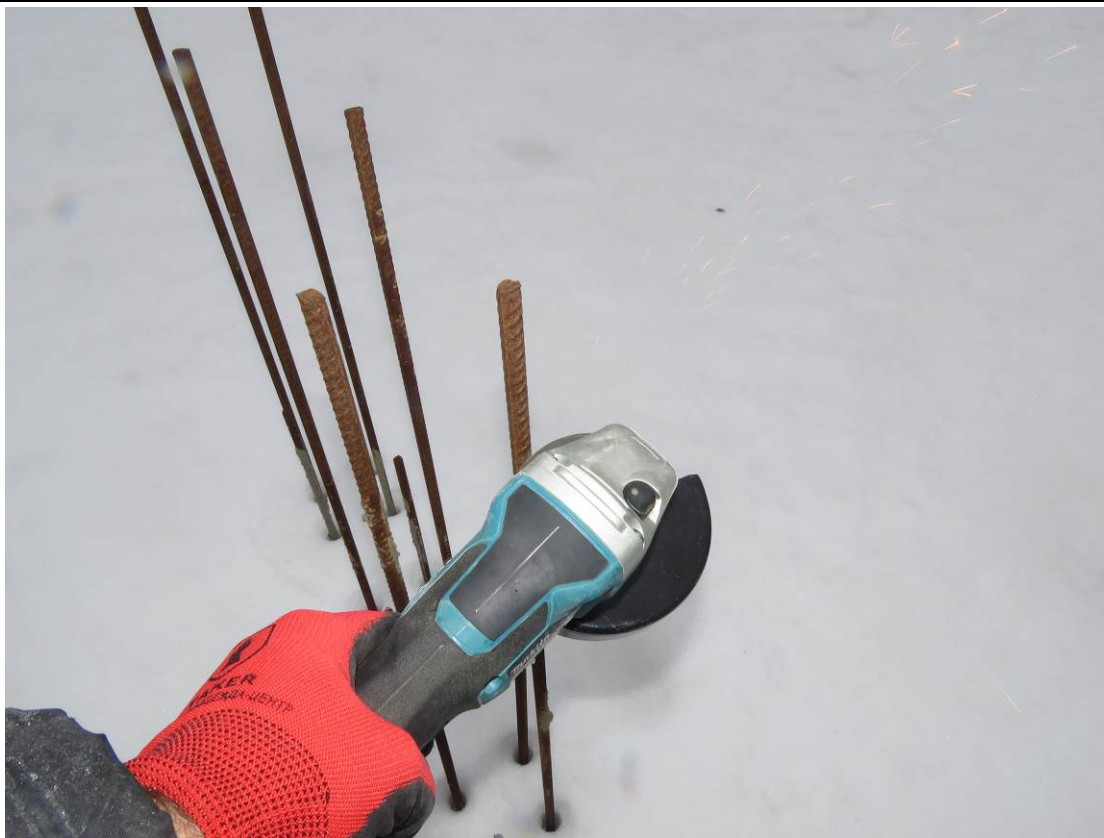
Рис. 3.2.9.Общий вид отбора проб арматурных стержней из арматурных выпусков под пилоны 1-го этажа секции 2
