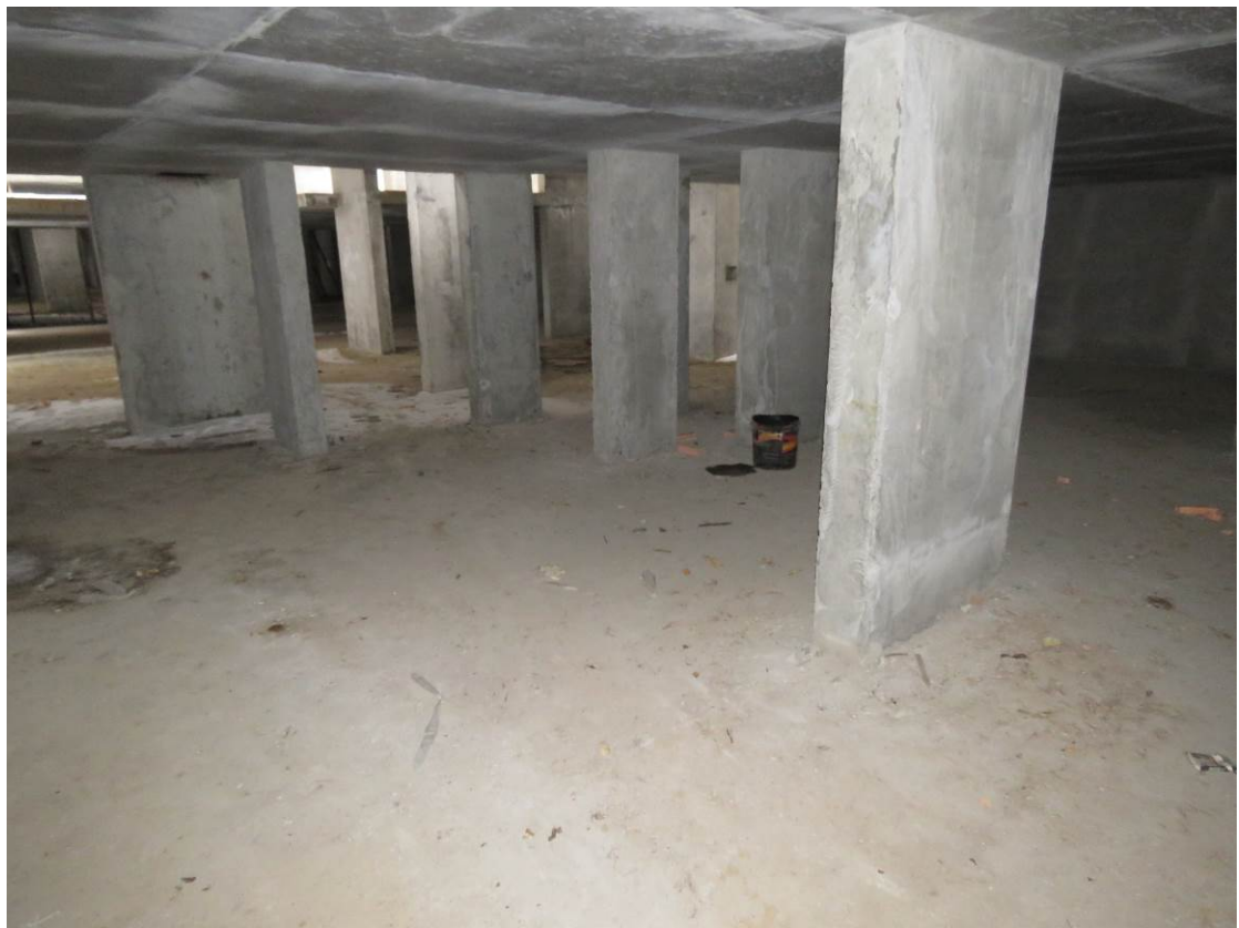
Рис. 1.4. Общий вид внутреннего пространства подвального этажа секции 5
